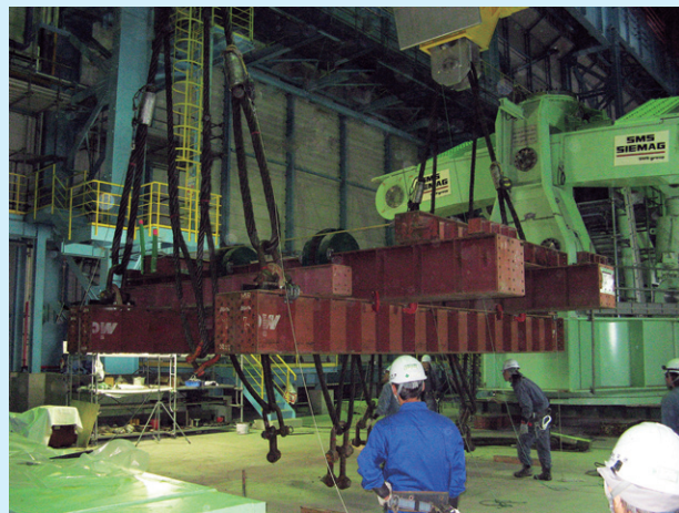
③ 500t クレーンにてレードルターレット 吊り上げ段取り中
