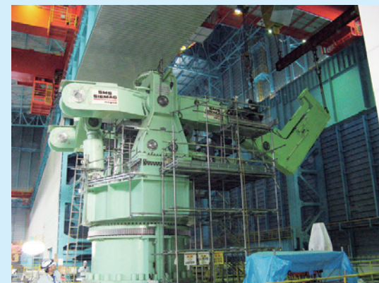
⑥ サドル取り付け作業
