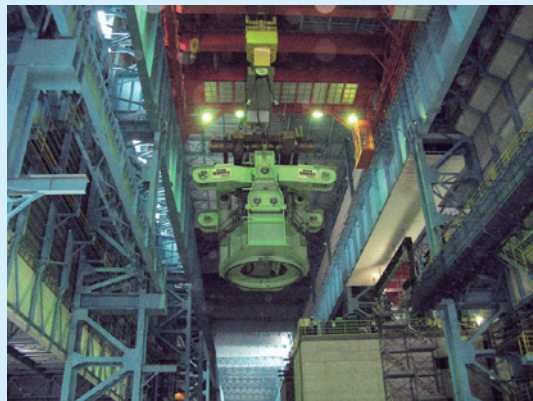
④ レードルターレット吊り上げ
