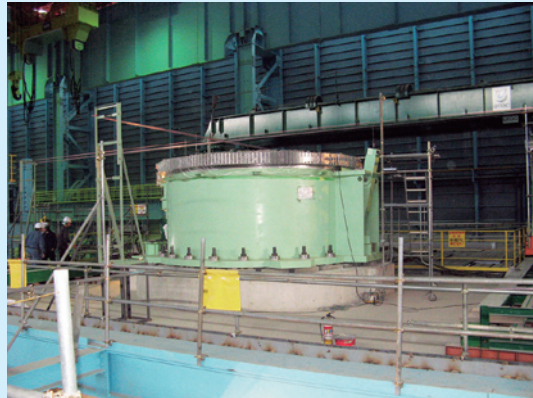
① 50t のターレットコラム芯出し作業中
