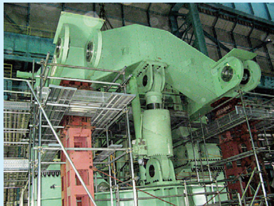
② レードルターレット組立中約 250t
