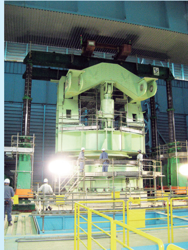
⑤ パワーリフターでコラムヘッドッキング
